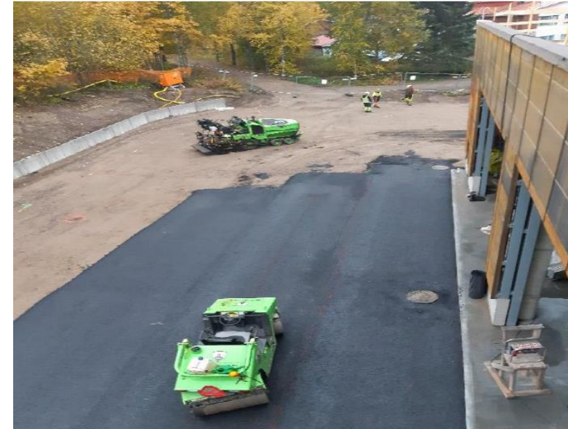
Asfaltin levitys käynnissä
