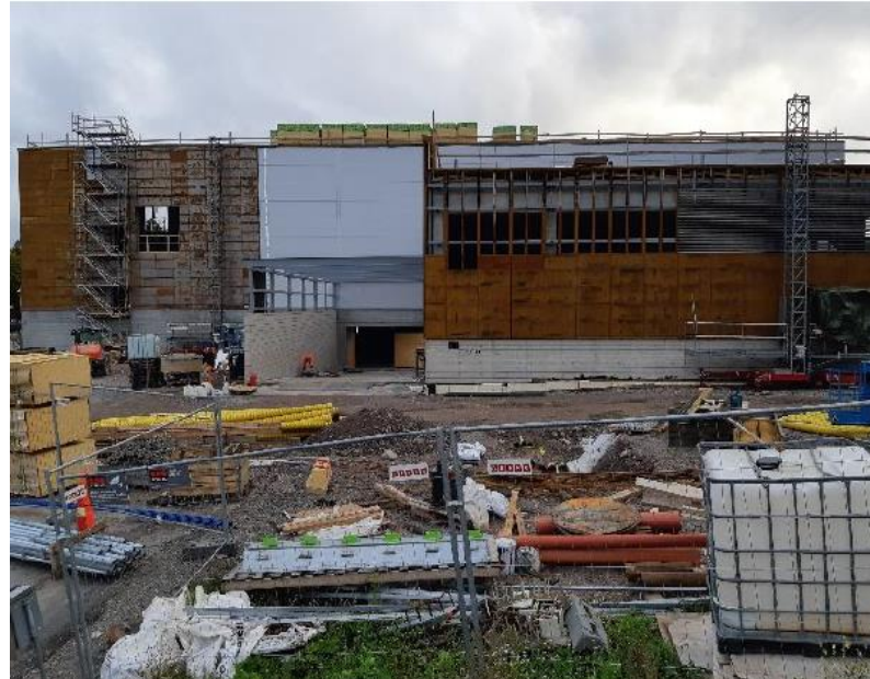
Näkymä ABC:lta työmaalle
