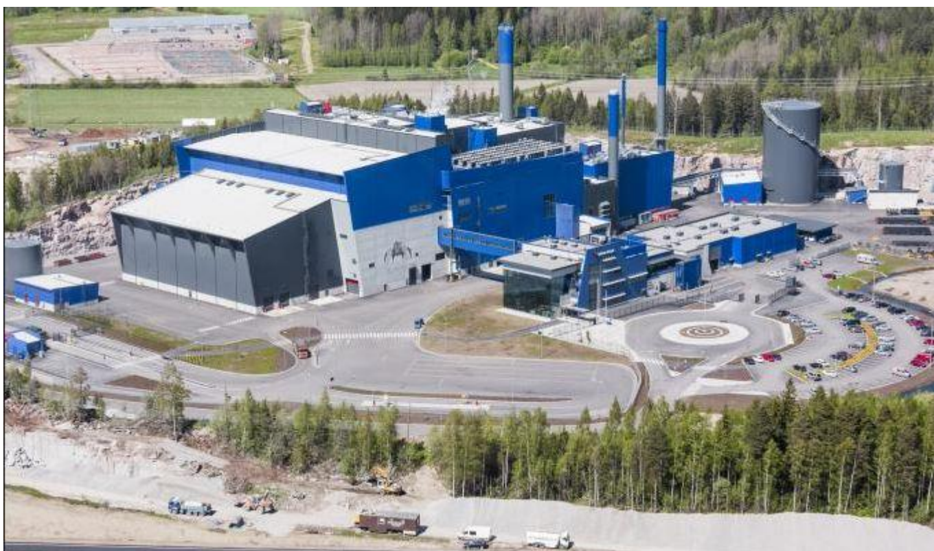
Vantaan jätevoimala (kuva: www.poyry.fi/projektit/vantaan-jatevoimalaitos )
